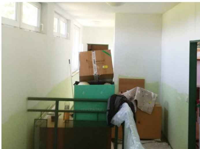
Pohled do chodby 2. nadzemního podlaží v kabinách při výmalbě povrchů.
