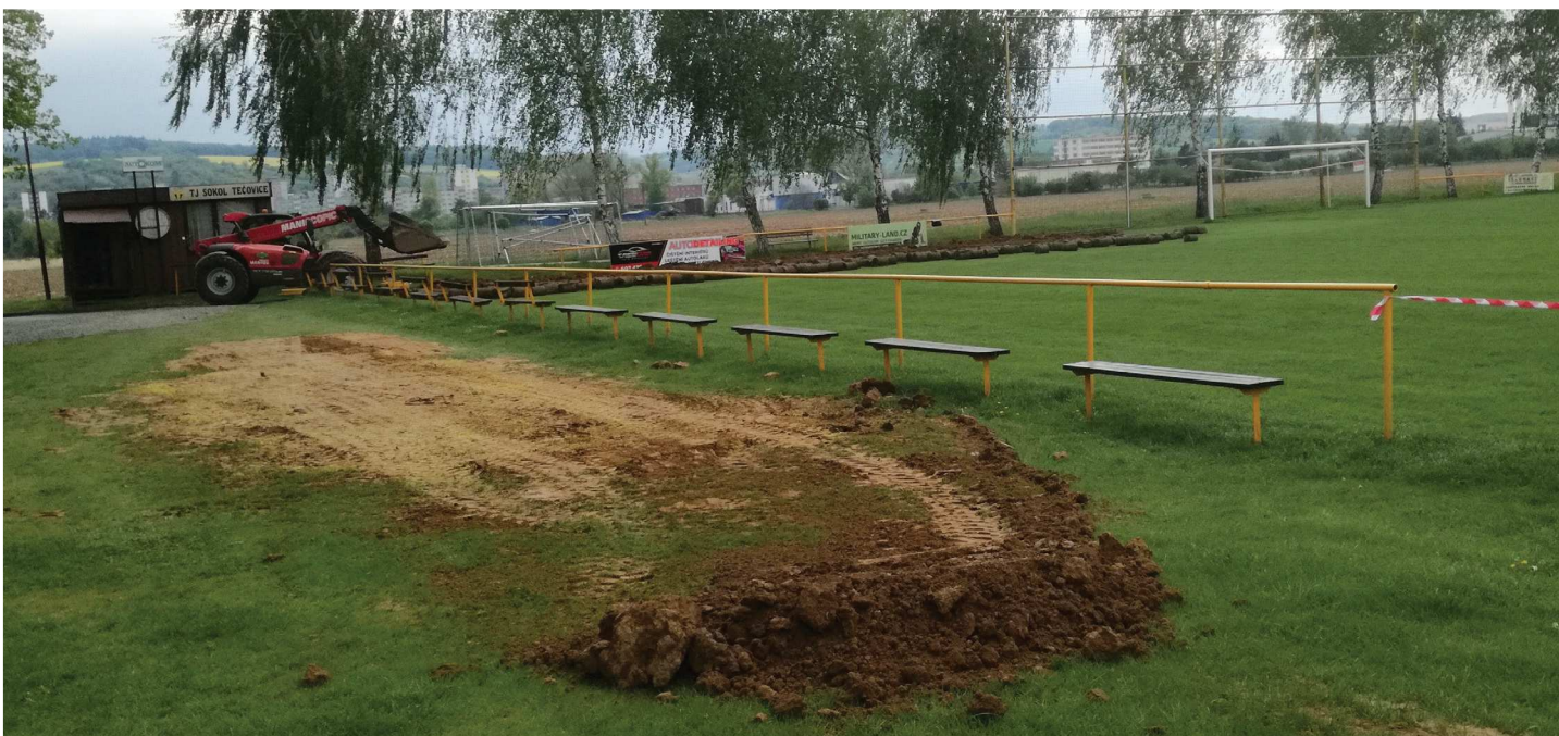
Úprava jihovýchodního nároží hrací plochy vyrovnáním – odebraná deponie zeminy.
