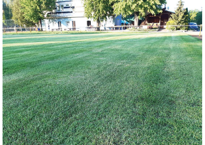
Úprava jihovýchodního nároží hrací plochy - detail po položení travního koberce. Foto: Daniel Mahdal
