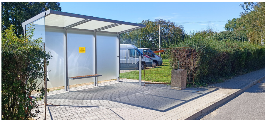
Ve směru z Tečovic do Malenovic obec vybudovala novou zastávku MHD.
