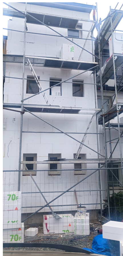
Budova obecního úřadu se zatepluje a dostane také novou fasádu.
