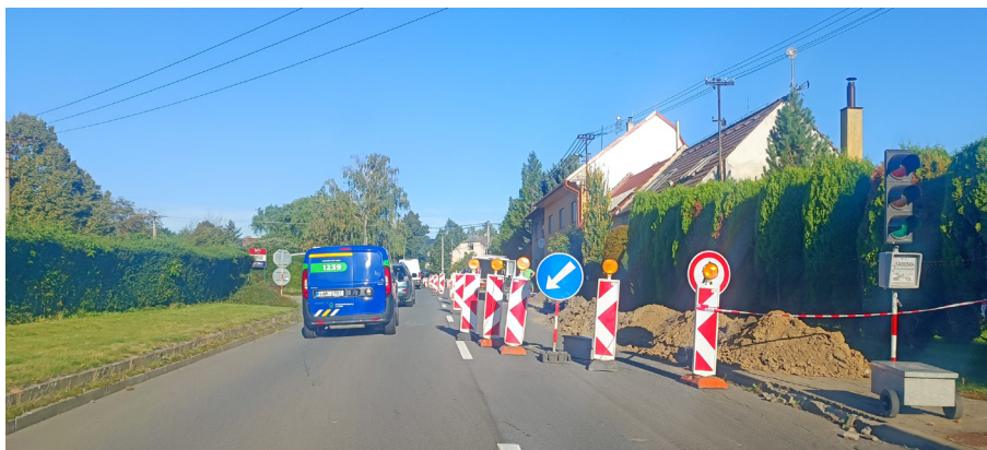
Specializovaná firma pokládá inženýrské sítě, jako silovou elektřinu i optický kabel pro rychlejší připojení k internetu. Provoz budou řídit semaforey do půlky října.
