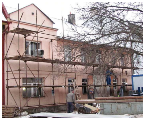
Rekonstrukce obecního domu č. p. 145 – stav v lednu 2019. Foto: Vojtěch Cekota
