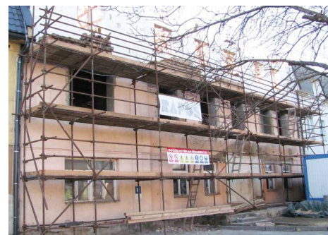
Rekonstrukce obecního domu č. p. 145 – stav v březnu 2019. Foto: Vojtěch Cekota
