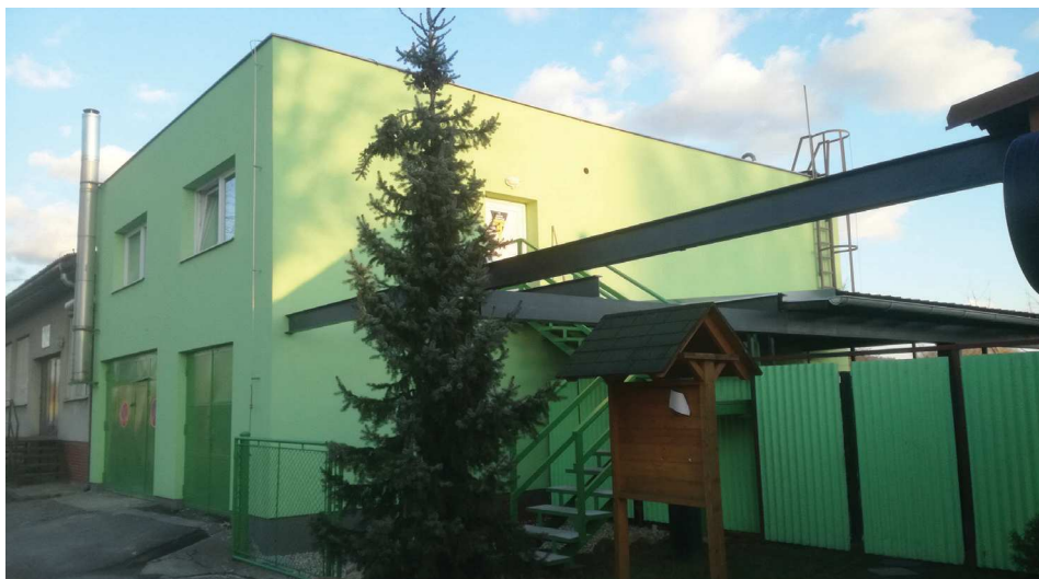
Pohled na fasádu, nástupní schodiště a oplocení dvora dokončené investice opravy klubovny TJ s technickým zázemím (dílňou a garážemi) od západu.
