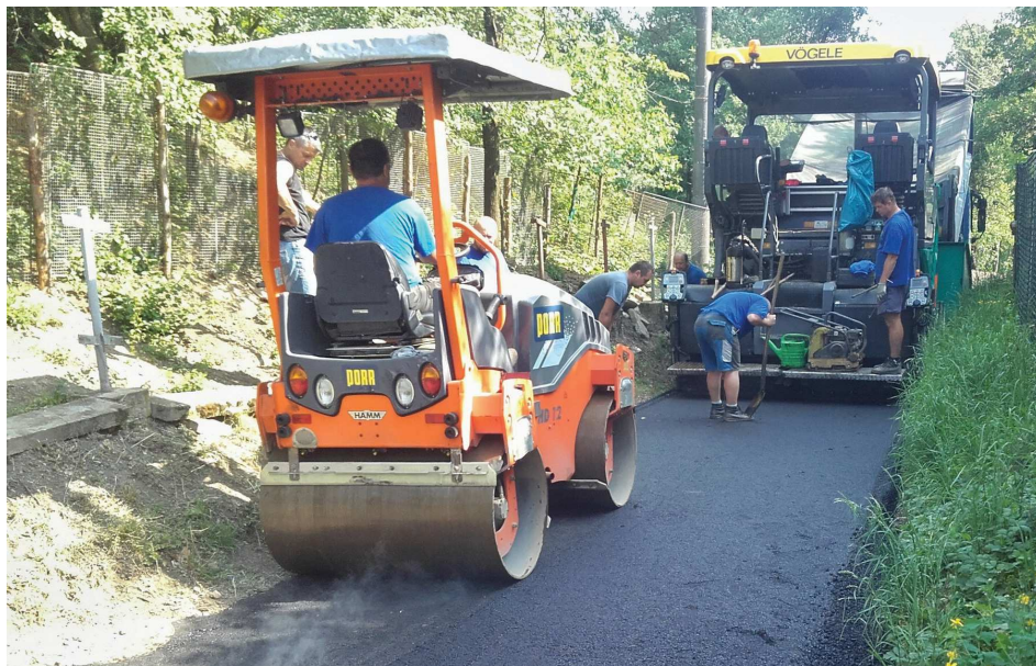
Obnova živичného povrchu vozovky v uličce nad hospodou.
