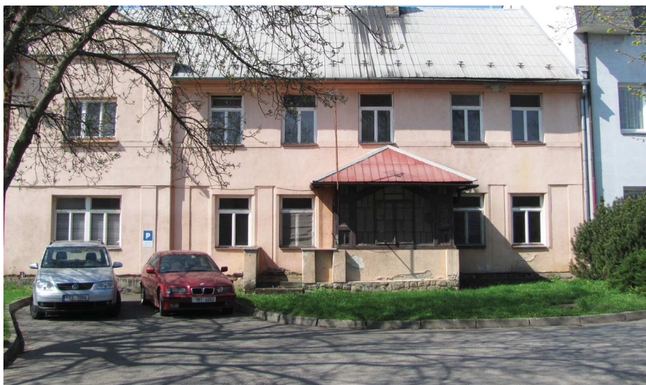
Dům č. p. 145 před rekonstrukcí.
