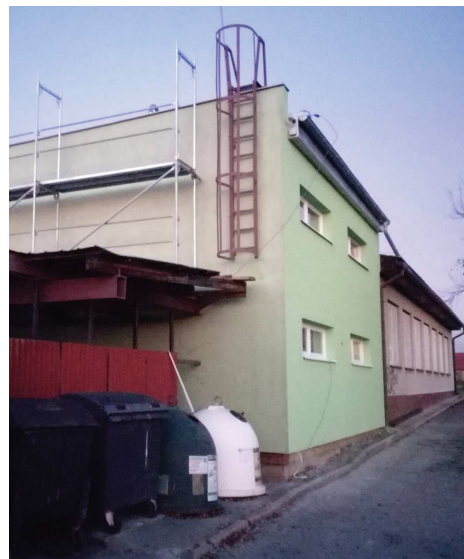
Dokončovací práce na zateplení a omítkách klubovny těsně před dokončením. Foto: Vladimír Kundera
