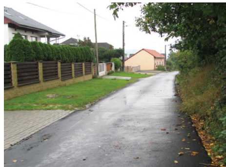
Obnovená vozovka v lokalitě Za Humny II.
