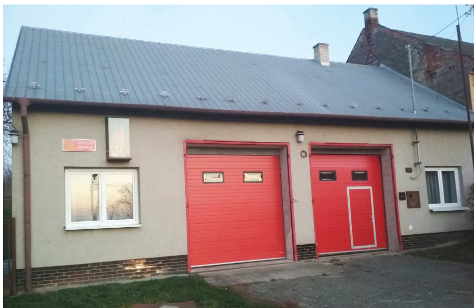
Opravená hasičská zbrojnice.
