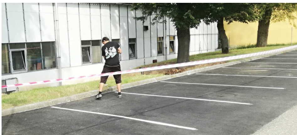
Aleš Ondík při posledních povrchových úpravách vodorovného značení parkoviště.
