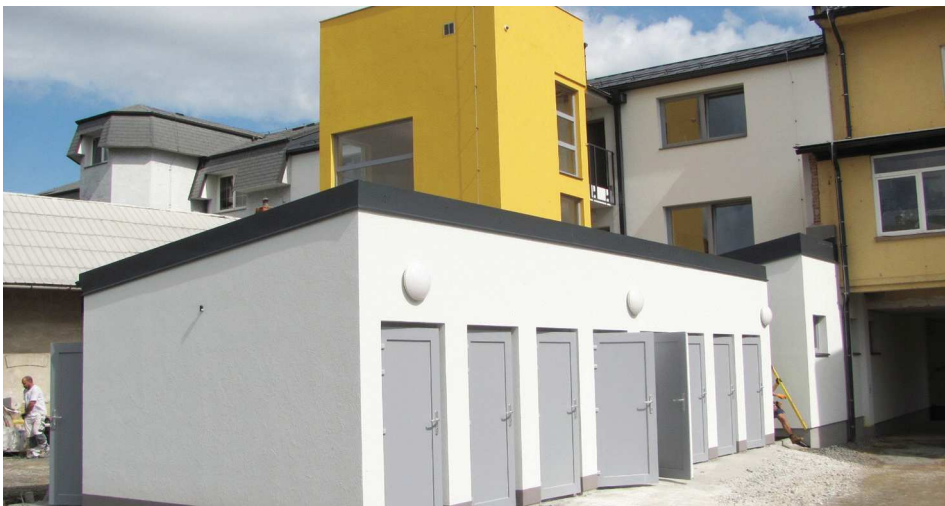
Rekonstrukce domu č. 145 se blíží ke svému závěru.
