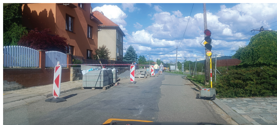
Rekonstrukce chodníku ke hřišti a přeložka osvětlení budou brzy hotovy a předány k užívání. Zatím je provoz v ulici řízen semaforem.
