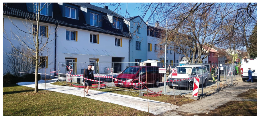
Čilý stavební ruch je nyní okolo obecního úřadu. Finišují tam práce na nové podobě prostoru před úřadem i v zadní části ve dvoře.
